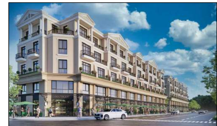
MẪU NHÀ PHỐ ĐIỂN HÌNH
